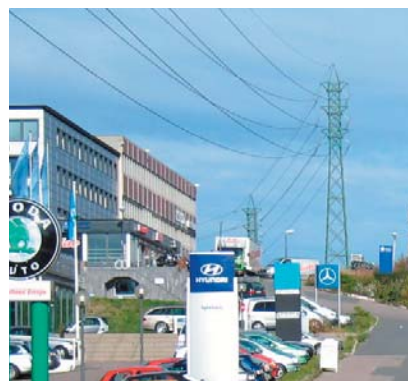
Høyspentledningen langs Ensjøveien graves ned.
