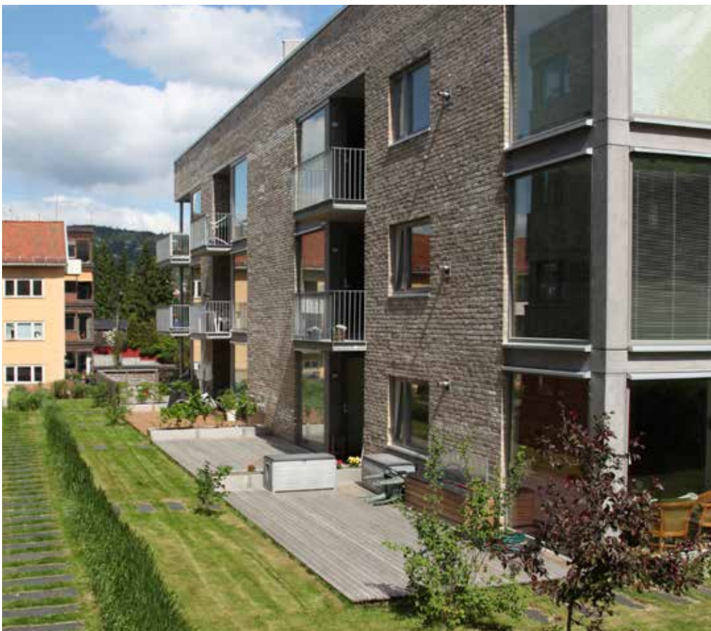
Røa hage, Oslo. Leilighetene i første etasje har privat uteplass på terreng. Leilighetene i øverste etasje har privat takterrasse, mens de øvrige leilighetene har romslige balkonger. LPO arkitekter, 2008.
